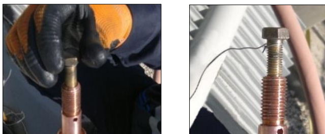
شکل ۲۷ پیچاندن پیچ M12 داخل سوراخ رزوه شده بالایی سرکابل و اتصال سیم کمکی به آن Fig. 27 Screwing a M12 bolt into draw-lead top bore and connecting a helping wire
