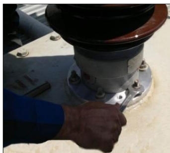
شکل ۲۹ بستن مهره‌های ناحیه اتصال فلنج بوشینگ به ترانس Fig. 29 Firming the screws of bushing's installation flange
