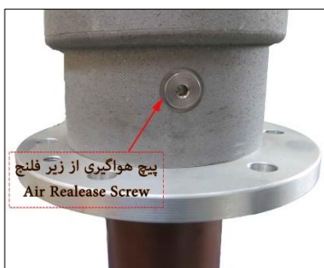
شکل ۳۲ پیچ هواگیری برای خارج نمودن هوای محبوس شده در ترانس از زیر فلنج بوشینگ
