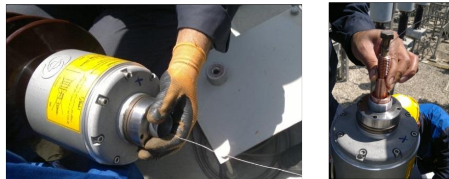
شکل ۲۸ عبور دادن سرکابل و کابل مسی افشان از داخل بوشینگ با استفاده از سیم کمکی Fig. 28 Using a helping wire to pass draw-lead and soldered cable through bushing
