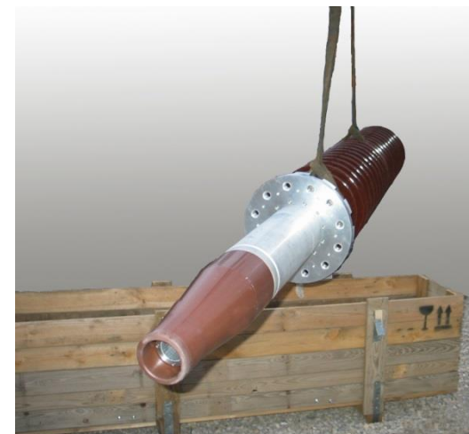
شکل ۶ خارج کردن بوشینگ از جعبه حمل
