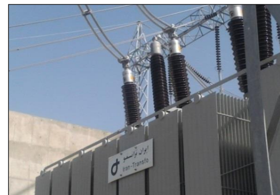
شکل ۲ نمایی از بوشینگ نصب شده روی ترانس در محل پست Fig. 2 Bushings installed on transformer on site
