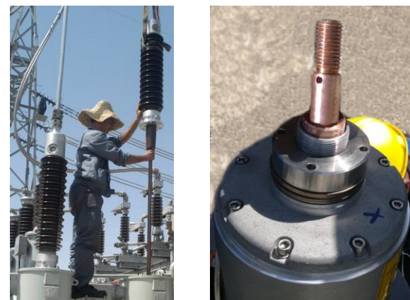
شکل ۲۶ عبور دادن هادی مسی از داخل بوشینگ برای نصب آن روی ترانس
